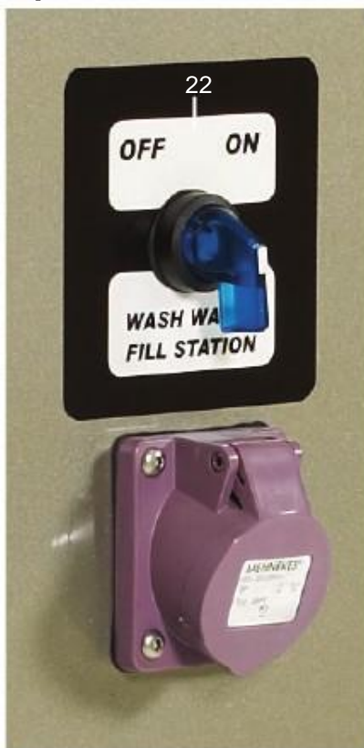
Рис. 5.4. Панель управления заполнения бака системы промывки льда.
